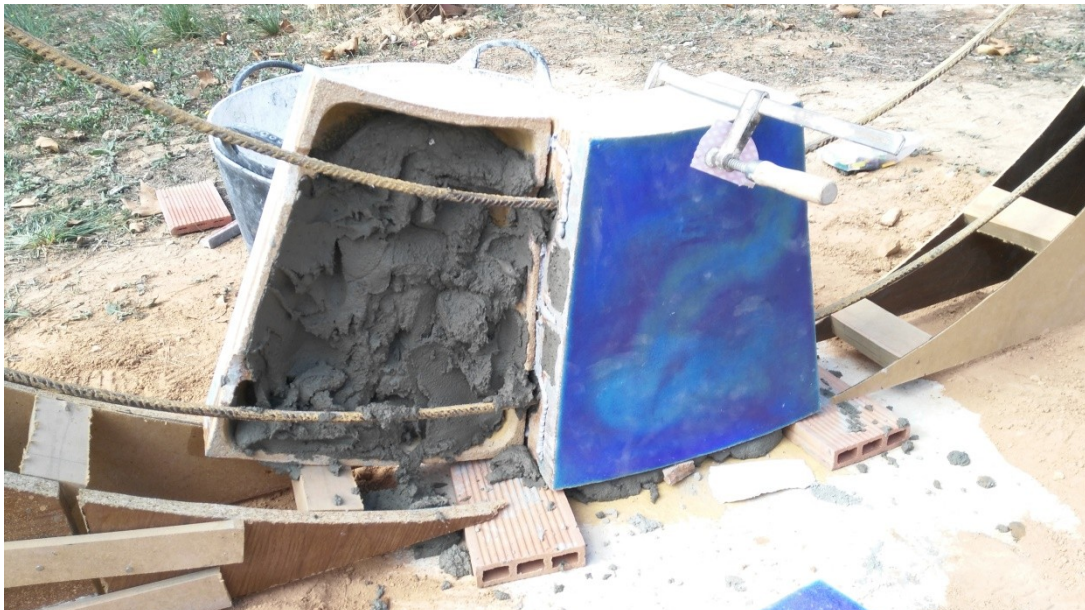
Figura 17: Inicio de la construcción
