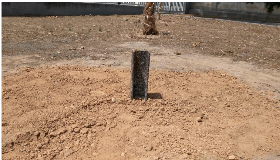
Figura 14: Pilar de HEB de 100, de 35cm
