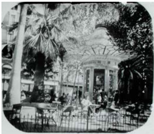
Figura 30: _MG_5402. Kiosco en Portal de Elx. Alicante.
