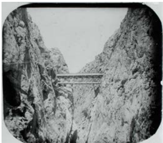
Figura 21: _MG_ 5350. Puente ferroviario. Probablemente de la línea Alcoi-Xàtiva o Alcoi-Gandía (Xixarra). Principios del XX.
